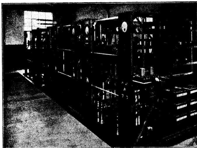
STAZIONE TRASMITTENTE A FASCIO DI BRIDGWATER COSTRUITA DALLA MARCONI'S WIRELESS TELEGRAPH COMPANY LTD. PER L'UFFICIO GENERALE POSTE INGLESÌ SU SISTEMA MARCONI ONDE CORTE.
