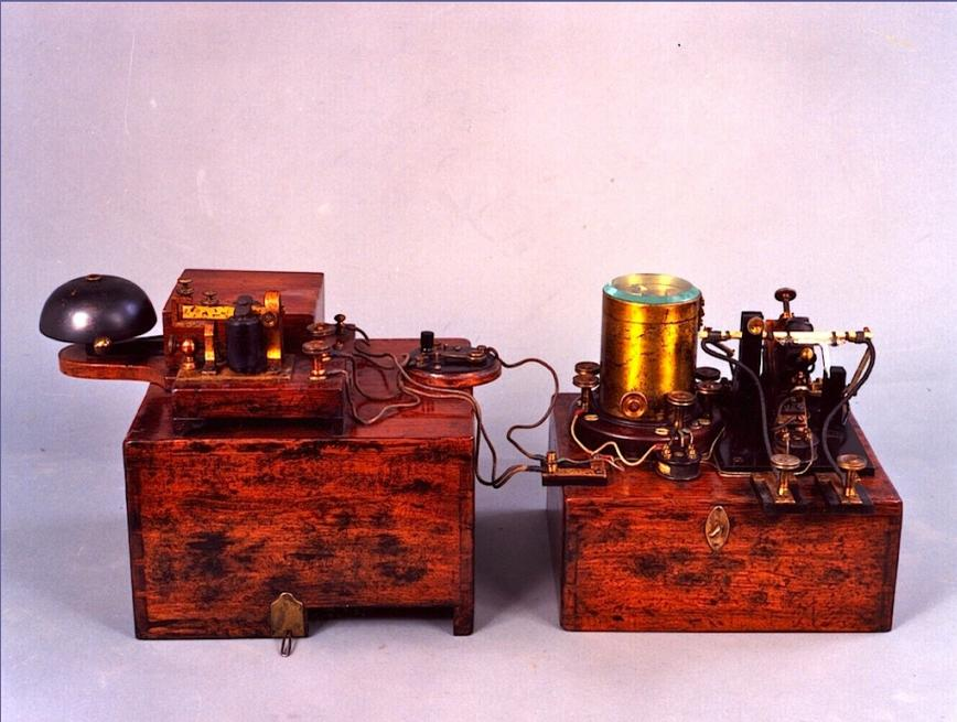
Ricevitore a coesore realizzato e impiegato da Marconi nelle prime esperienze di radiotelegrafia, 1895-1897.
